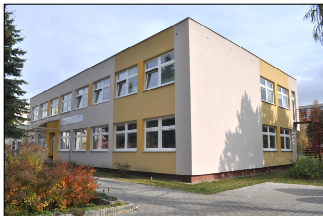
Obrázok č. 2 Budova školy po zateplení
