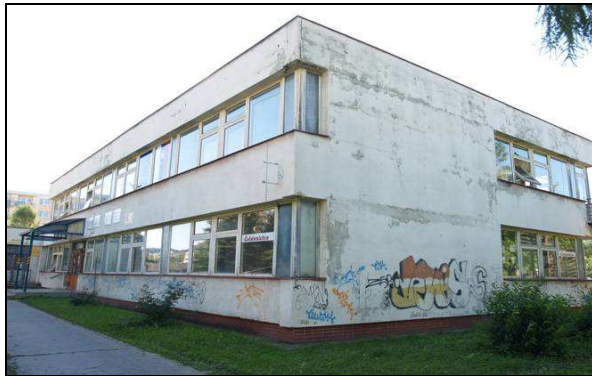
Obrázok č. 1 Budova školy pred zateplením
