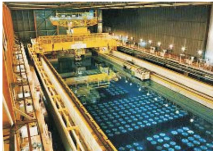
Wypalone paliwo zanurzone w wodzie w basenie przechowawczym
