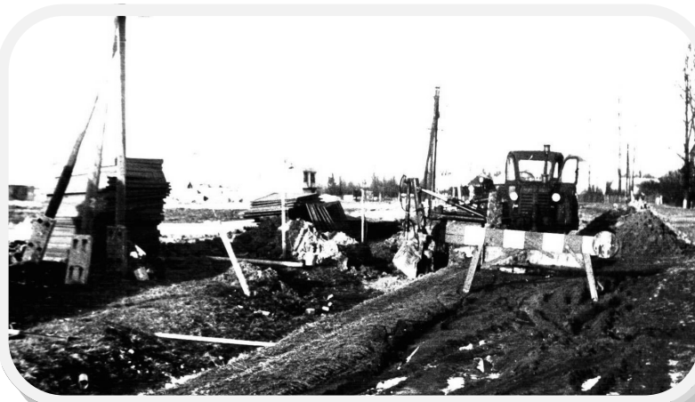
Widok na plac budowy od strony Drochlina – 1976r.
