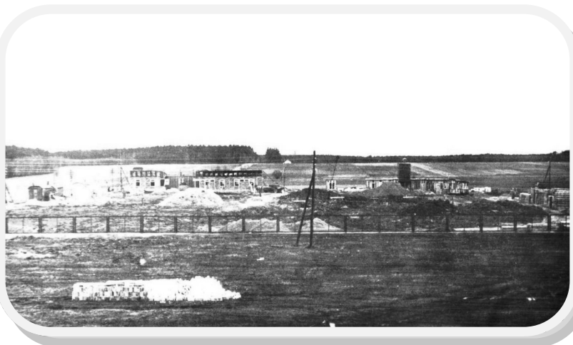
Widok na plac budowy od strony centrum – 1976r.
